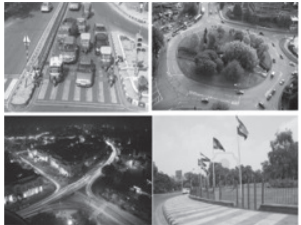
चित्र 12 — गोलचक्कर, फ्लाईओवर के निर्माण का लाभ
